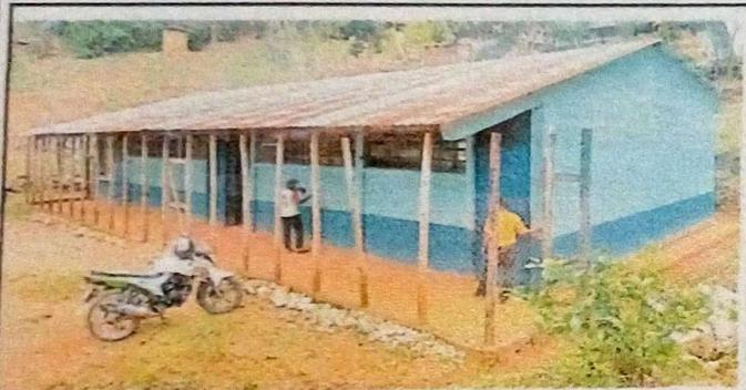
Foto 3: TECHO EN CONDICIONES DE OXIDACIÓN: El techo evidencia la presencia de óxido. (Miembros de OPF realizando mediciones)
